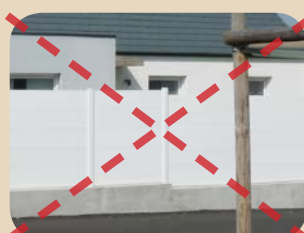
Murets surmontés de panneaux opaques PVC non ajourés assimilables à des murs plastiques
