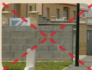
Murs en parpaings non enduits
